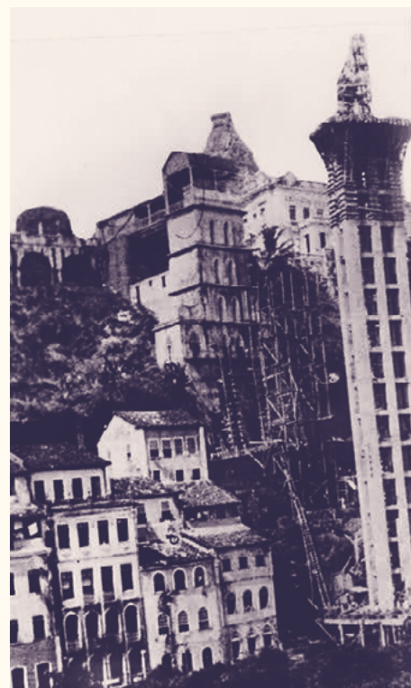
FIGURAS 7 E 8. ELEVADOR LACERDA EM REFORMA NA DÉCADA DE 1930.
