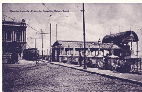
FIGURAS 3 E 4. ELEVADOR HIDRÁULICO DA CONCEIÇÃO.
